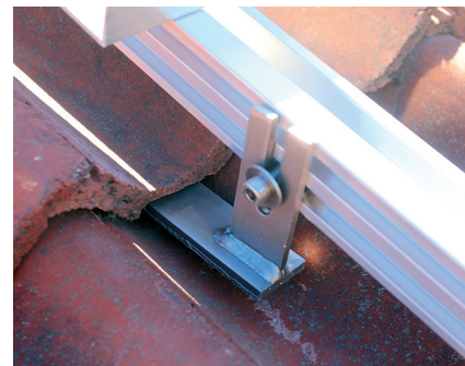
Palatiilikaton kiinnike
