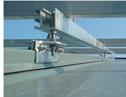
Konesaumatus peltikaton kiinnike vastaa lumiasteiden kiinnikettä. Reikiä ei tarvita.
